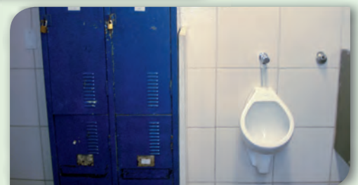
Inadequado... Armário do vestiário colocado dentro do banheiro!
